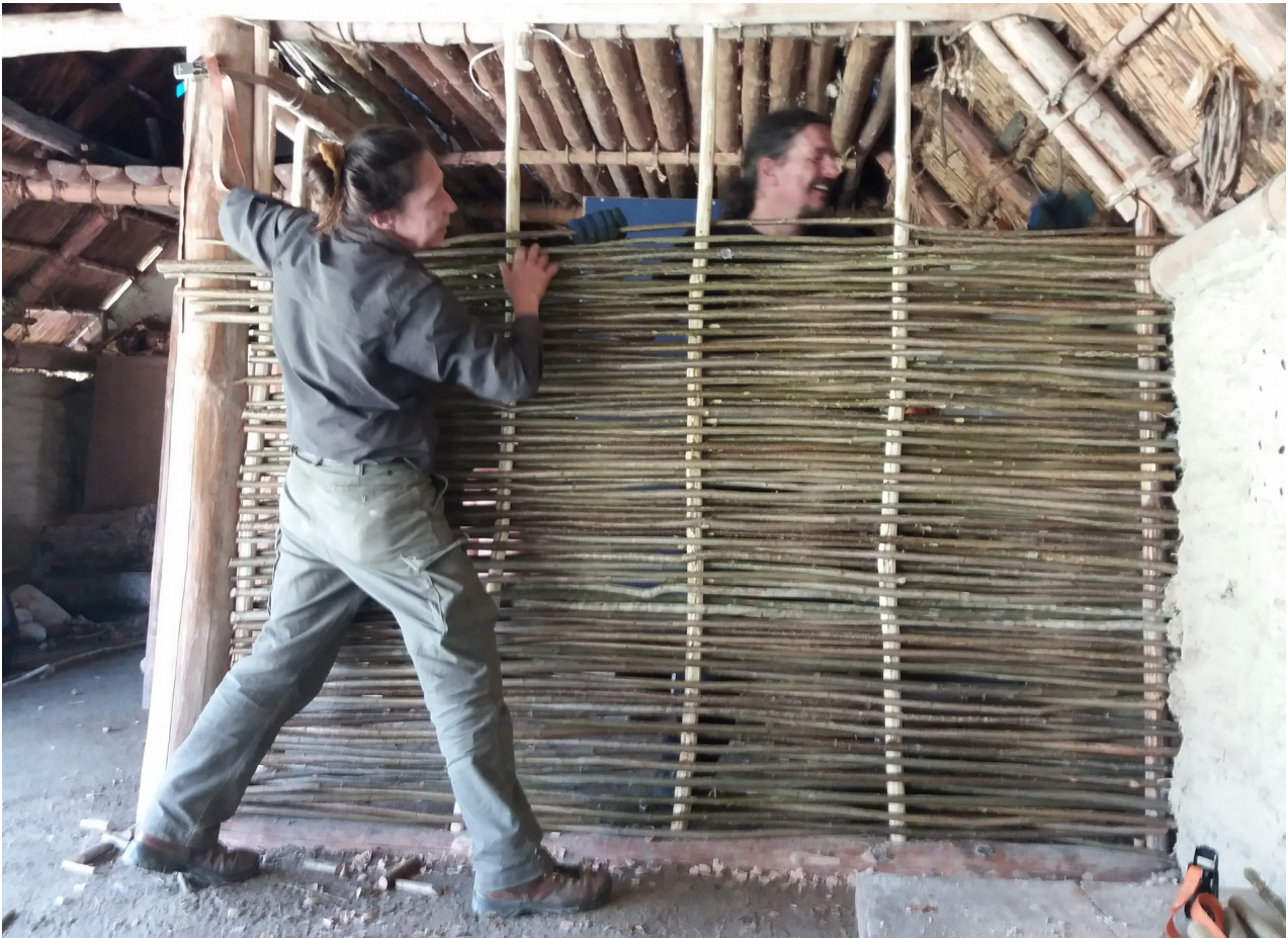
Un mur de l'atelier en cours de reconstruction
